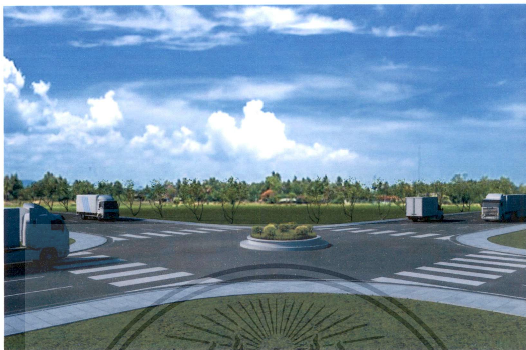
ภาพที่ 5.6 แสดงการลดผลกระทบทางรถโดยจัดทำวงเวียนบริเวณสี่แยกถนนเทศบาล 1 และถนน เทศบาล 14 กับถนนยุทธศาสตร์
