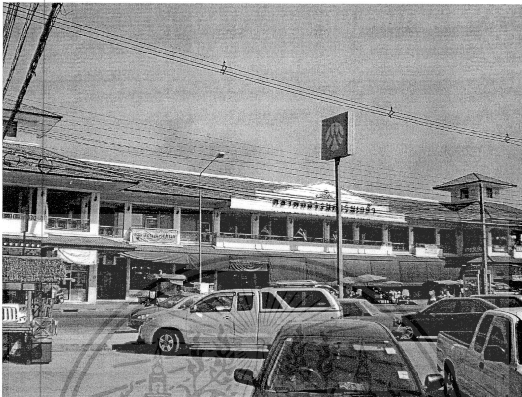
ภาพที่ 4.14 ภาพถ่ายตลาดกลางชุมชนการเคหะร่มเกล้า (ถ่ายเมื่อวันที่ 17 ตุลาคม 2554)
