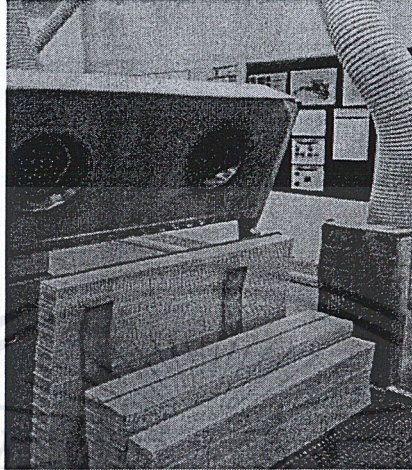
รูปที่ 3.10 เครื่องดูดฝุ่นที่ติดตั้งไว้อยู่เดิมแล้วกับเครื่อง GWO4
