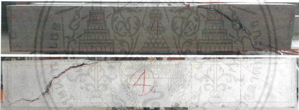
รูปที่ ก-4 ลักษณะการแตกหักของคานคอนกรีตเสริมเหล็กตัวที่ 4
