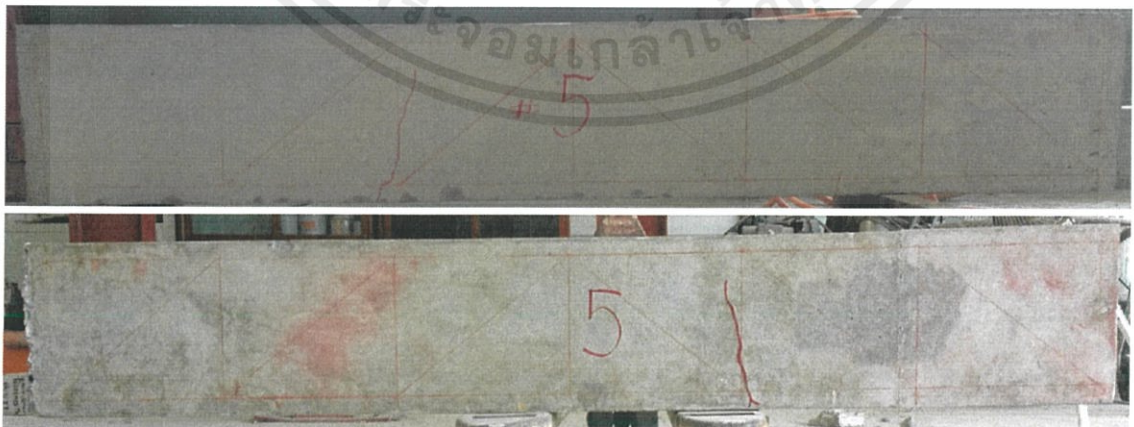
รูปที่ ก-5 ลักษณะการแตกหักของคานคอนกรีตเสริมเหล็กตัวที่ 5
