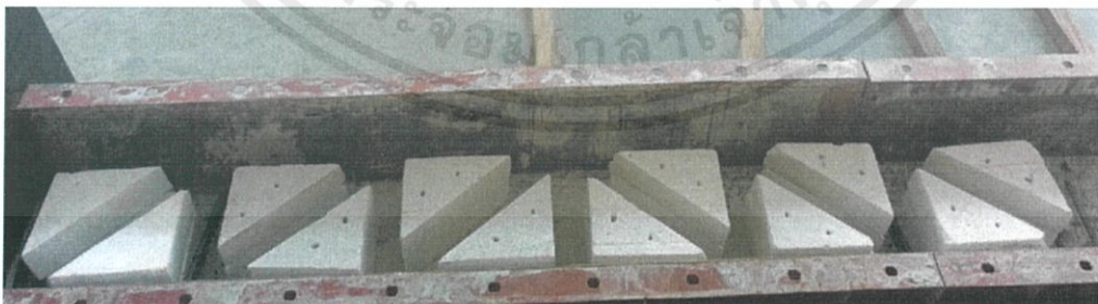
รูปที่ 3.3 การประกอบแบบหล่อคอนกรีต
