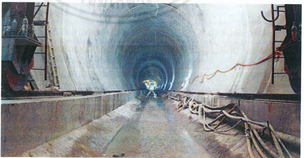
รูปที่ 2.5 Shotcrete finish lining
