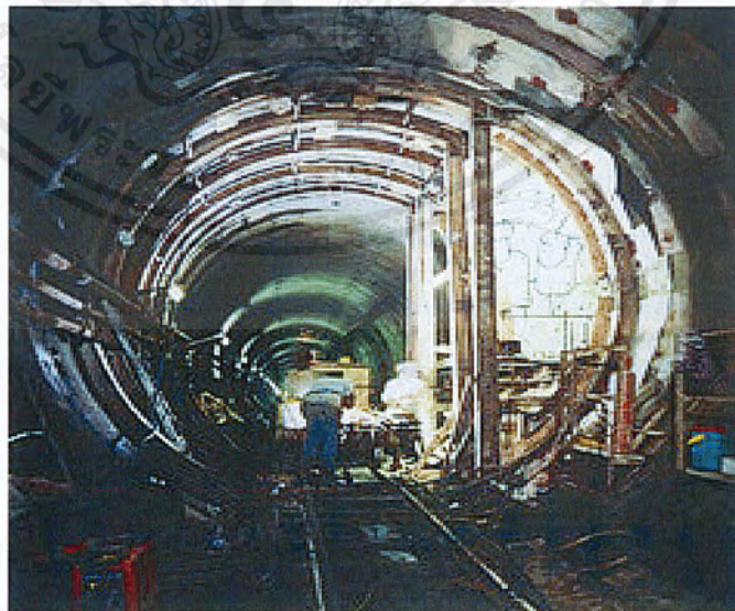
รูปที่ 2.7 Los angeles metro – โครงสร้างพร้อมกับ Barrel stave lining
