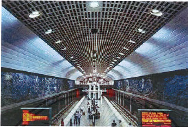
รูปที่ 2.2 Peachtree center station, MARTA, Atlanta – reinforced rock
