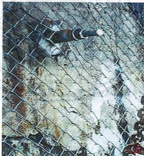
รูปที่ 2.3 Rock bolts with wire mesh
