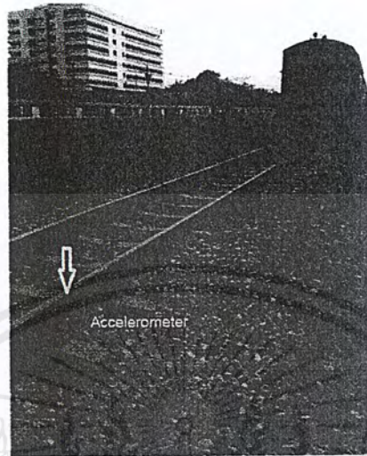
รูปที่ 3.10 ติดตั้ง Accelerometer ที่เลน 1 วัดค่าเมื่อมีรถไฟโดยสารผ่าน
