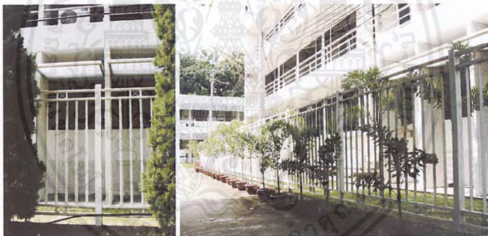
ภาพที่ 5.29 แสดงรั้วกั้นบริเวณอาคารผู้ป่วยใน
