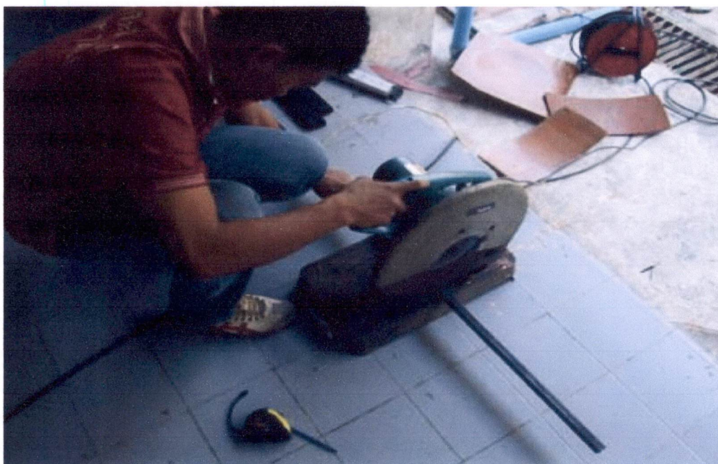
ภาพที่ ง 25 แสดงภาพการตัดเหล็กให้ได้ตามขนาดที่ต้องการ
