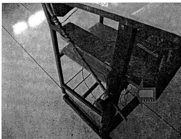
ภาพที่ 2.19 สายไฟที่มีสภาพไม่เรียบร้อยของโต๊ะดราฟงานเขียนแบบ วิทยาลัยอาชีวศึกษา ฉะเชิงเทรา
