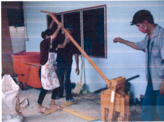
รูปที่ ก-28 แสดงการอัดบล็อกประสานด้วยเครื่องอัดแรงคน
