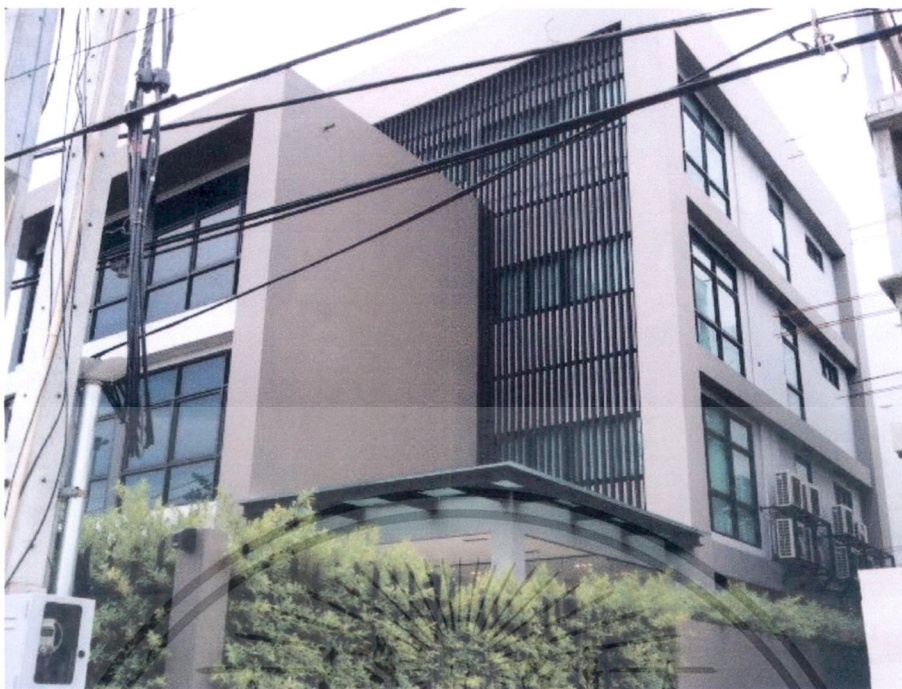
ภาพที่ 5.16 อาคารกรณีศึกษาก่อนการปรับปรุง
