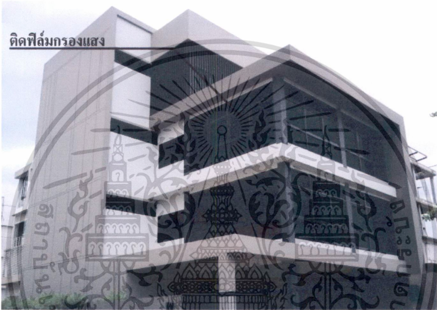
ภาพที่ 5.18 อาคารกรณีศึกษาหลังจากติดฟิล์มกรองแสงสีดำ
