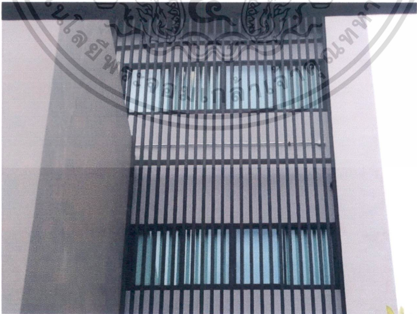
ภาพที่ 3.35 ผังคอนกรีตมวลเบามีหน้าต่างและอุปกรณ์บังแดดแนวตั้ง
