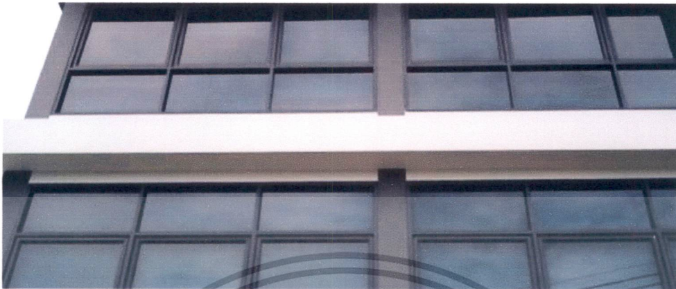
ภาพที่ 3.36 ผนังคานคอนกรีต
