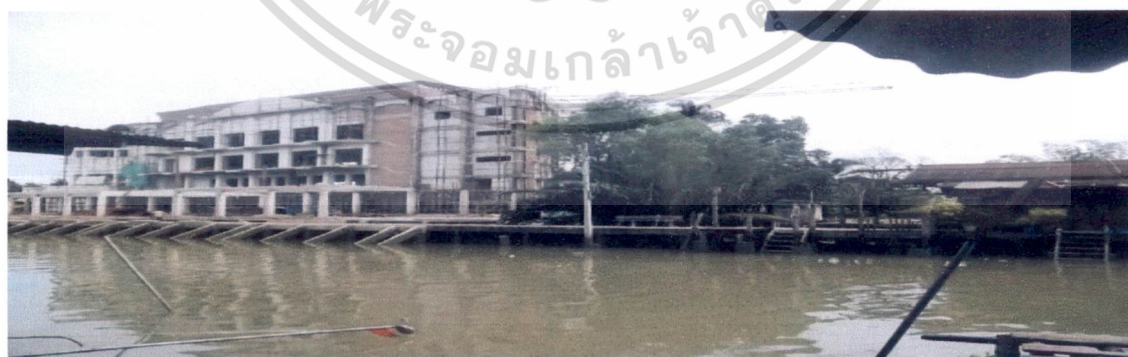
ภาพที่ 4.3 แสดงทัศนียภาพเรือนแถวไม้พื้นถิ่นถูกรื้อถอนเพื่อสร้างโรงแรมระดับห้าดาว
