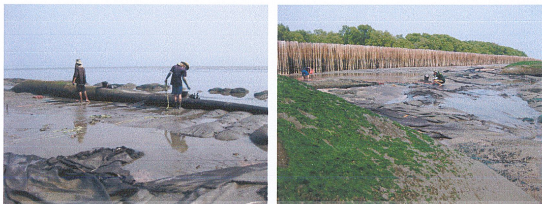
ภาพที่ 6 แสดงการเปรียบเทียบระดับการรั่วไหลของถุงแผ่นใยสังเคราะห์บรรจุทราย (ซ้าย : ถุงแผ่นใยสังเคราะห์บรรจุทราย ถุงที่ 2, ขวา: ถุงแผ่นใยสังเคราะห์บรรจุทราย ถุงที่ 3)
