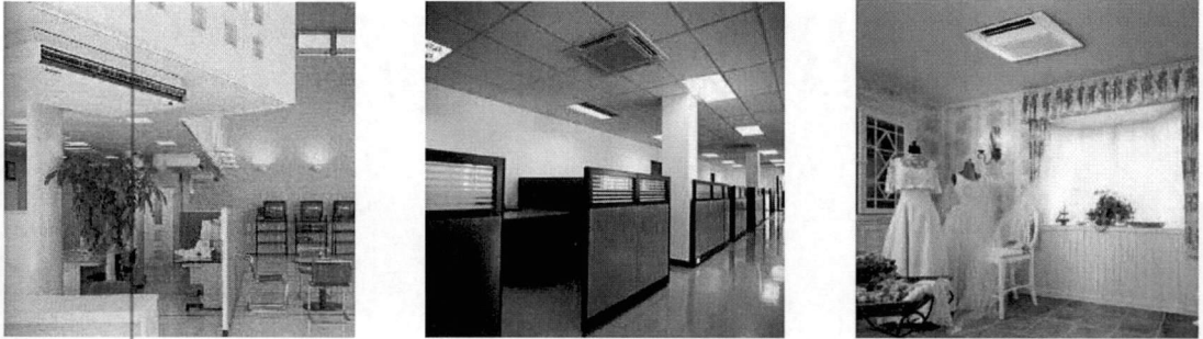
ภาพที่ 3.10 ตัวอย่างการติดตั้ง Indoor Unit ประเภทต่าง ๆ ที่มา : (สมาคมวิศวกรรมปรับอากาศแห่งประเทศไทย. 2552)
