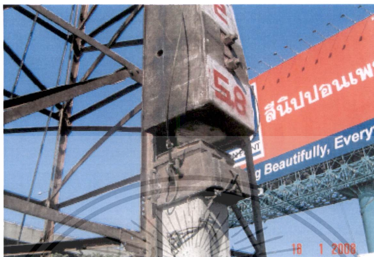
ภาพที่ 3.18 การตอกเสาเข็มท่อนแรก
