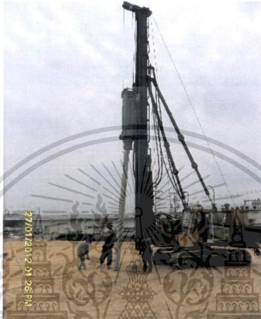
ภาพที่ 3.2 ปั่นจั่นรถดินตะขาบ ที่มา: บริษัท ปั่นจั่นไทย จำกัด. 2554
