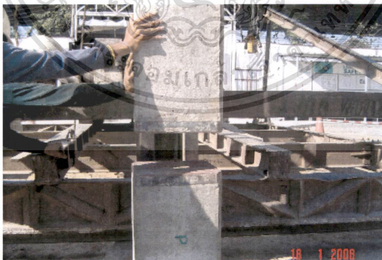
ภาพที่ 3.19 ปันจันลากลากเสาเข็มท่อนที่สองขึ้นเพื่อเตรียมต่อเชื่อม
