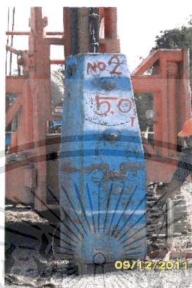
ภาพที่ 3.4 ระบบการตอกเสาเข็มแบบต้อนปล้อยตกรกระแทก
