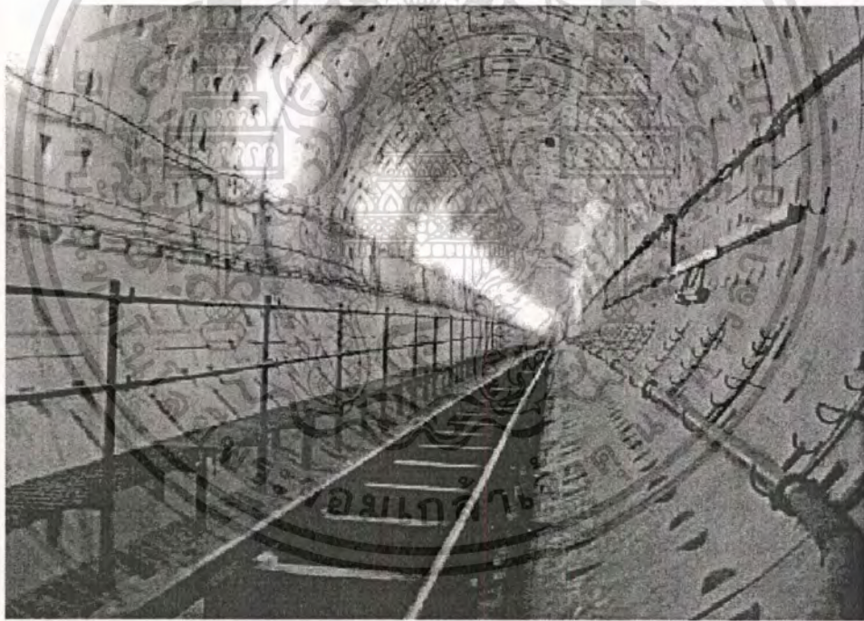
รูปที่ 2.5 ผนังอุโมงค์คอนกรีตเสริมเหล็กในโครงการรถไฟฟ้าใต้ดินสายเฉลิมรัชมงคล
