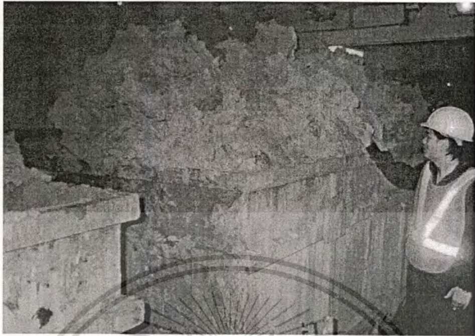
รูปที่ 2.4 รรรางลำเลียงดินที่ขุดออกจากอุโมงค์
