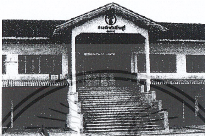
รูปที่ 5.20 อาคารที่ทำการศาลจังหวัดมีนบุรีหลังเก่า
