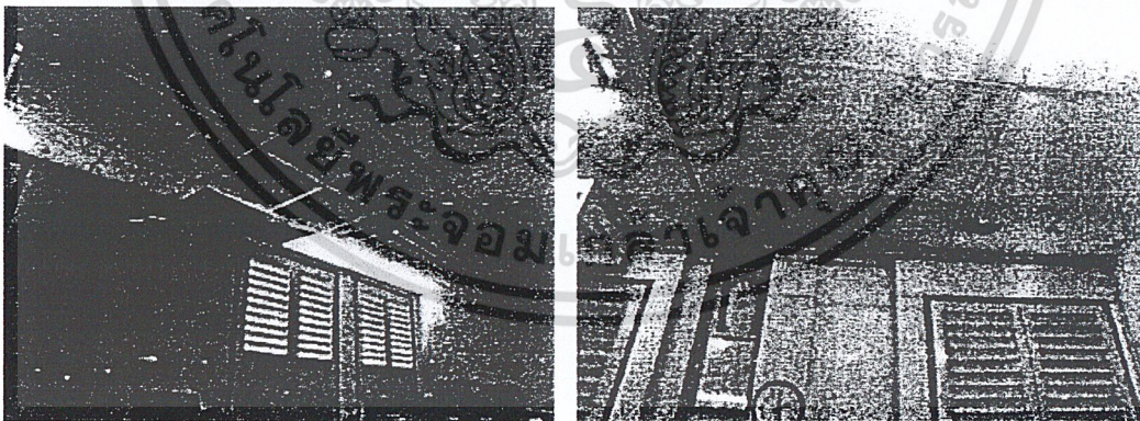
รูปที่ 5.8 และ 5.9 การชำรุดทรุดโทรมของฝ้าเพดานจากการระบายอากาศที่ไม่เหมาะสม
