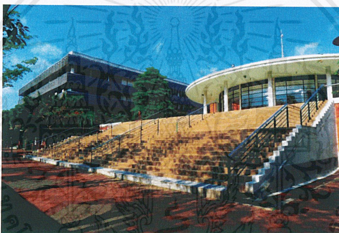
ภาพที่4.7 ตึกงานบินคณะสถาปัตยกรรมศาสตร์
