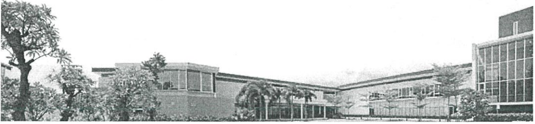
รูปที่ 2.2-6 สภาพอาคารโรงพยาบาลโดยรวม
