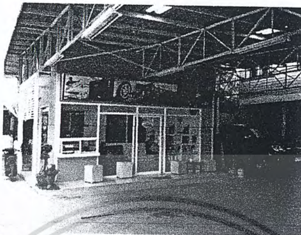
รูปที่ 1.1-5 บริเวณ ภายนอก ห้องรับรองลูกค้า ศูนย์บริการ โปลิ-เทค สาขา อ่อนนุช
