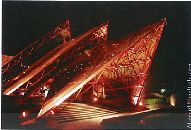
รูปที่ 3.2-3 แสดงลักษณะการใช้โครงเหล็กถักสำเร็จรูป (Space Frame) ของศูนย์การประชุมแห่งชาติสิริกิติ์
