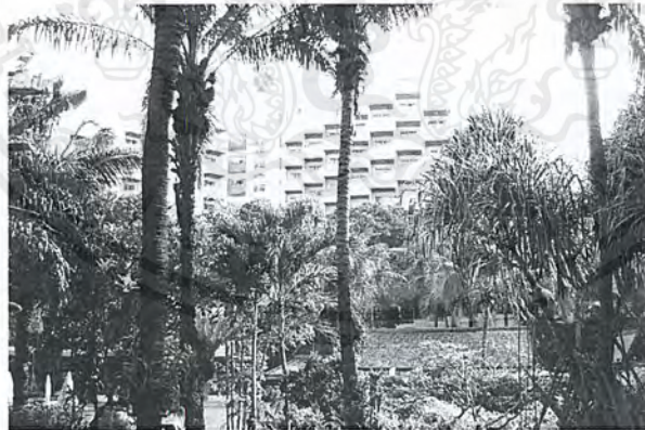
ภาพที่ 2.187 ลักษณะทางสถาปัตยกรรมภายนอกอาคารและสวน พัทยา แมริออท รีสอร์ท แอนด์ สปา
