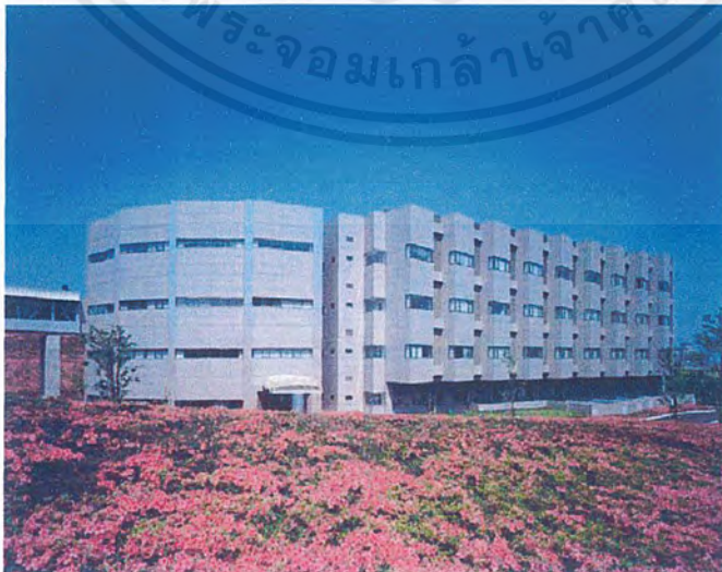
รูปที่ 3.30 แสดงมุมมองภายนอกทางด้านทิศตะวันตกของอาคารปฏิบัติการทดลอง
