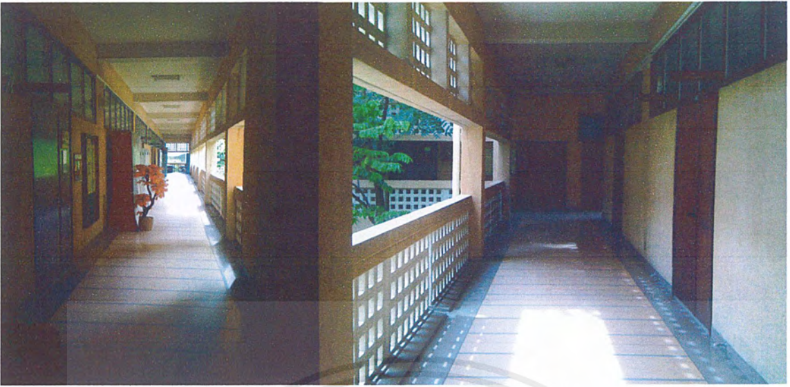
รูปที่ 3.7 แสดงมุมมองทางเดินภายในอาคารทั้งด้านยาวและด้านกว้าง
