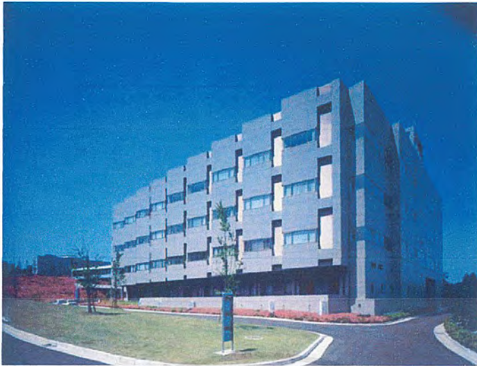
รูปที่ 3.31 แสดงมุมมองภายนอกทางด้านทิศตะวันออกเฉียงเหนือของอาคารปฏิบัติการทดลอง
