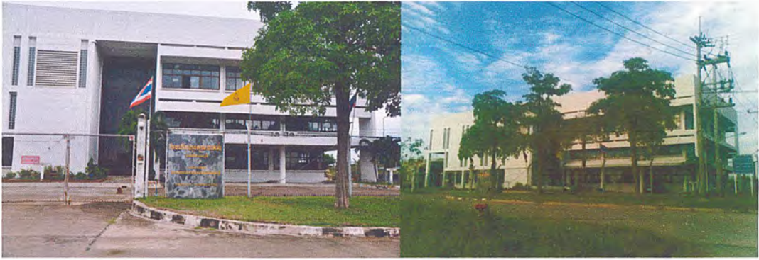
รูปที่6.11 แสดงโรงบำบัดน้ำเสีย
