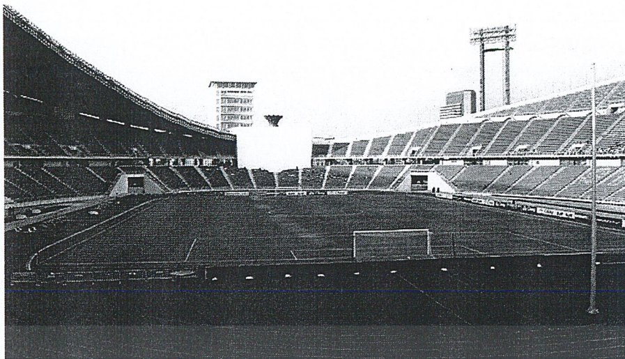
รูปที่ 3.9 ภาพแสดงอัฒจันทร์ที่นั่ง 2 ข้าง ที่มีหลังคาและไม่มีหลังคาคลุม ในราชมณฑลกีฬาสถาน
