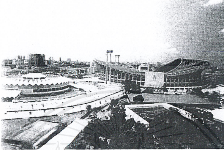
รูปที่ 6.23 โครงสร้าง Rigid Frame กับงานสนามกีฬาราชมั่งคลากกีฬาสถาน
