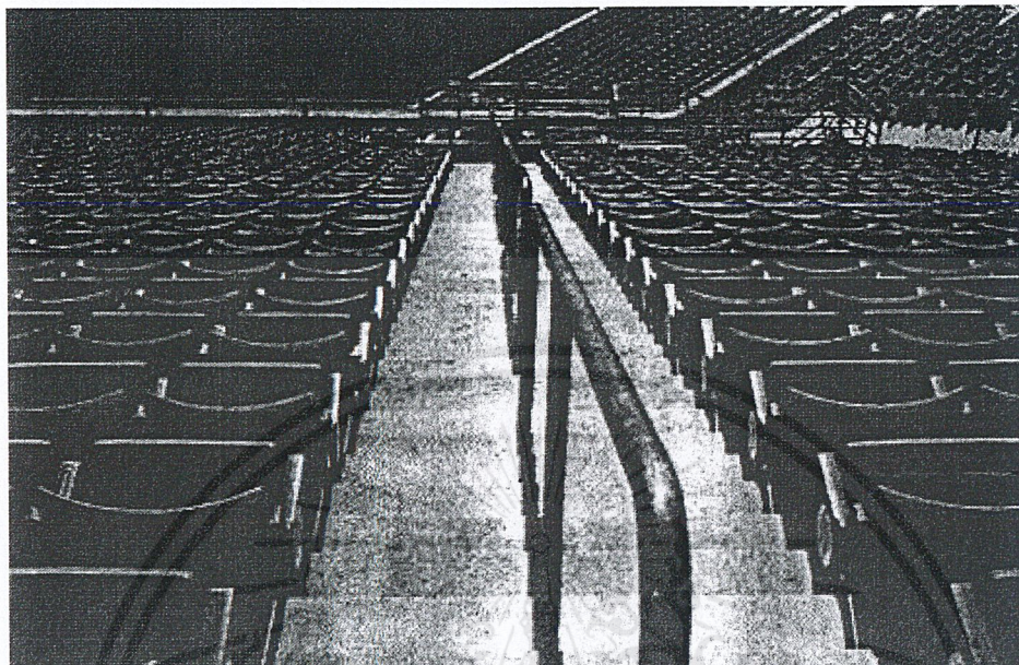
รูป 6.19 แสดงราวจับระหว่างบันไดทางเดินอัฒจันทร์ โดยวางตรงกลางเพื่อความเรียบร้อยของผู้ชมในการเข้าออกและกรณีฉุกเฉิน
