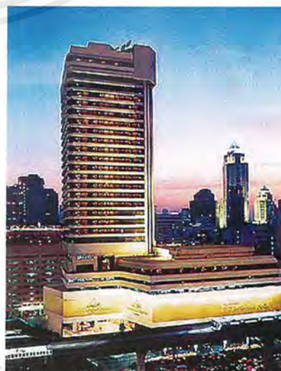
รูปที่ 1.2 รูปอาคาร
