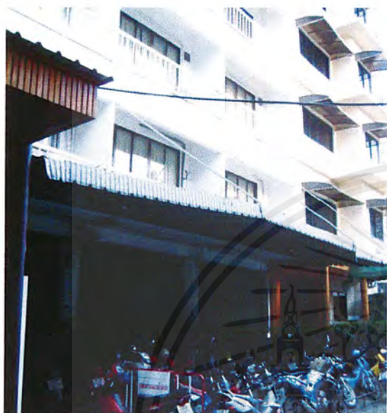
รูปภาพที่ 1.21 อาคารฝึกอบรมพนักงานสูง 5 ชั้น
