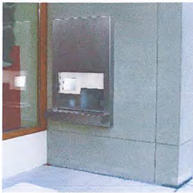
ภาพที่ 6.27 แสดงการติดตั้งอุปกรณ์รับคืนวัสดุอัตโนมัติภายนอกอาคาร
