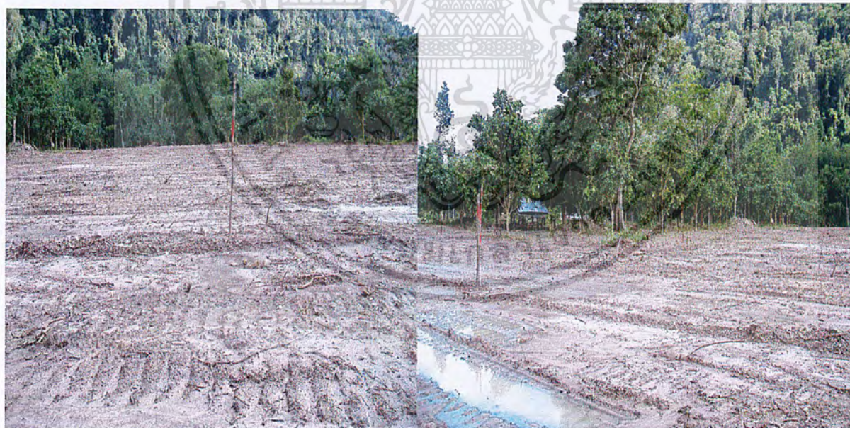
ภาพที่ 4. การปรับพื้นที่ก่อนการก่อสร้างอ่างเก็บน้ำ
