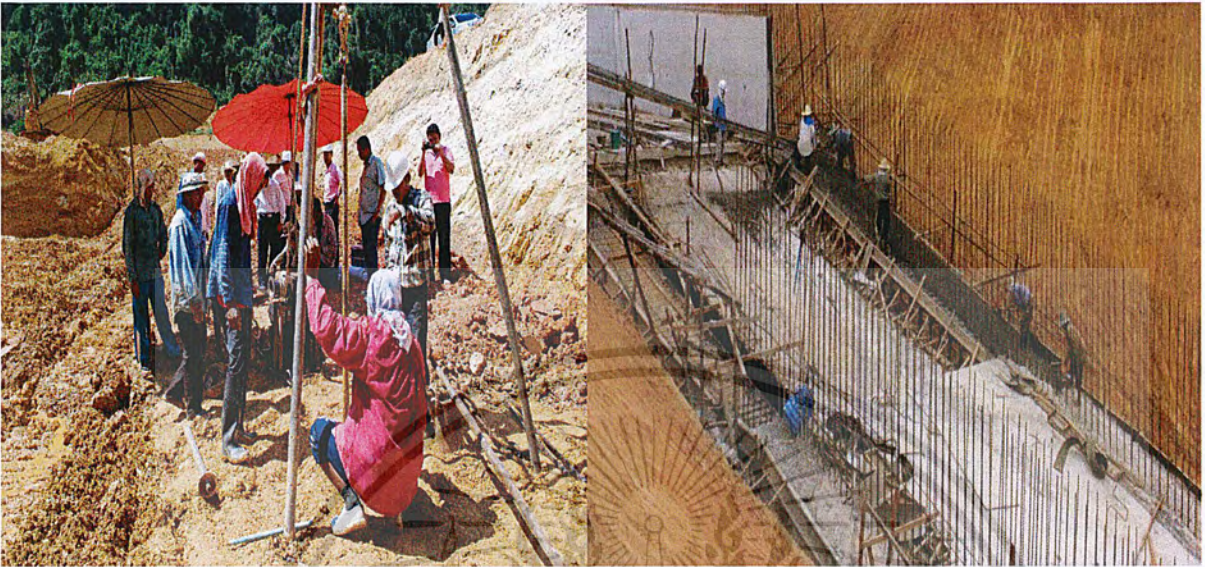
ภาพที่ 5 การก่อสร้างอ่างเก็บน้ำ
