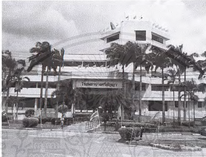
ภาพที่ 4.10 ตึกอำนวยการใหม่
