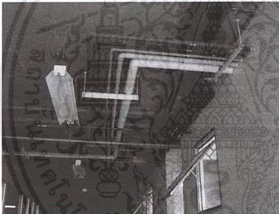
ภาพที่ 5.12 เนื่องจากท่อของ โครงการ โรงพยาบาลนั้นมีอยู่หลายชนิด โดยทั่วไปจะใช้สีในการแยกประเภทของท่อ
