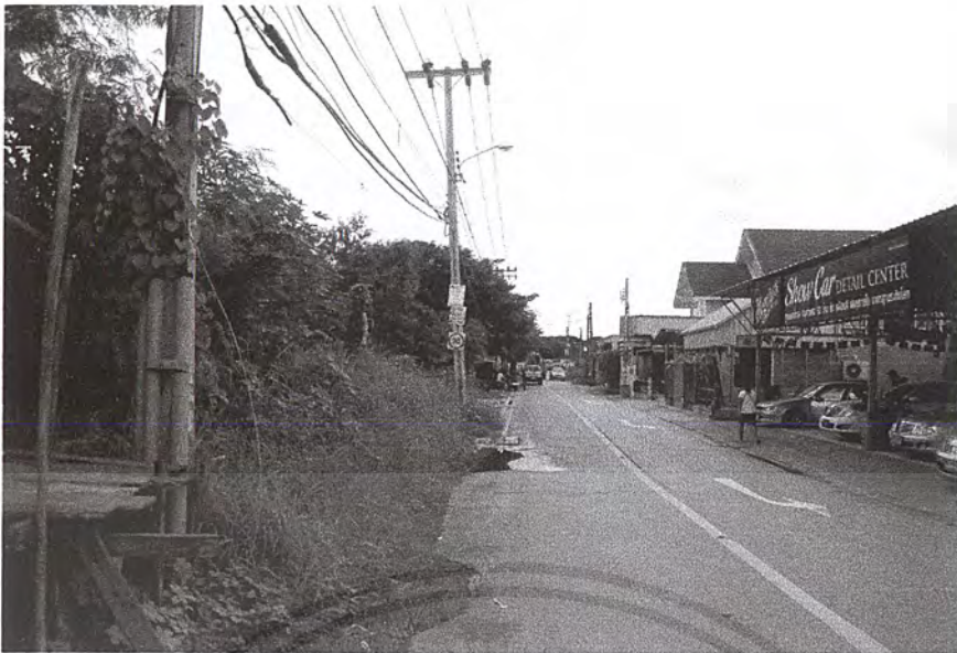
ภาพที่ 3.26 แสดงมุมมองในซอยทางด้านขวาของที่ดิน ด้านข้างเป็นอู่รถยนต์
