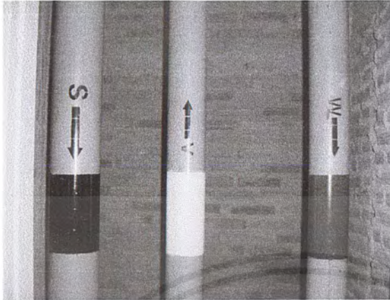
ภาพที่ 5.11 ในส่วนของท่อนั้นหากใช้วัสดุชนิดเดียวกันหรือสีเหมือนกันก็ต้องระบุหรือทำสัญลักษณ์ระบุให้ชัดเจน โดยในภาพ (S) คือ ท่อโสโครก (V) คือ ท่อระบายอากาศ (W) คือ ท่อน้ำทิ้ง
