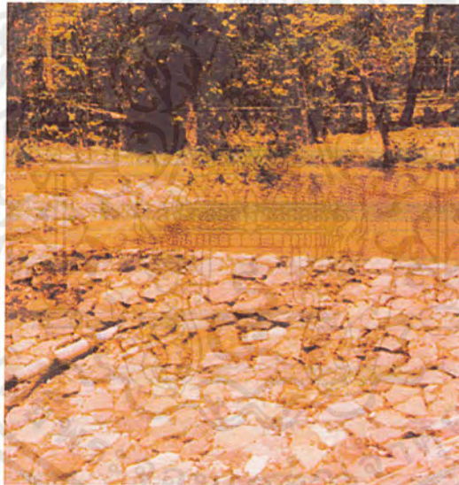
รูปที่ ค. 4 ฝายที่ก่อสร้างด้วยหิน
