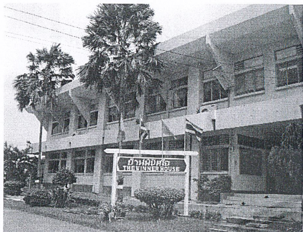
ภาพที่ 4.5 ทางเข้าด้านหน้าศูนย์
