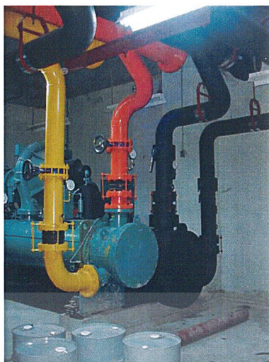
รูปที่ 6.1 เครื่องทำความเย็น, เครื่องสูบน้ำเย็นและเครื่องระบายความร้อน, แผงควบคุมและเครื่องลดความกระด้างของน้ำที่ใช้ในการส่งจ่ายน้ำเย็น โดยจะแยกท่อสำหรับส่งน้ำเย็นจะมีฉนวนหุ้ม
