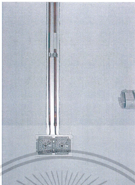
รูปที่ 6.12 การวางท่อแก๊สทางการแพทย์นั้น จะต้องเตรียมช่องท่อไว้ก่อนที่จะทำการเดินท่อไม่ควรฝังท่อลงในกำแพง โดยตรงเพราะท่อพวกนี้จะมีการสั่นเวลาที่ใช้ ซึ่งทำให้เกิดการแตกของผนังหรือท่อได้และยังสามารถดูแลรักษาท่อได้โดยง่ายด้วย
