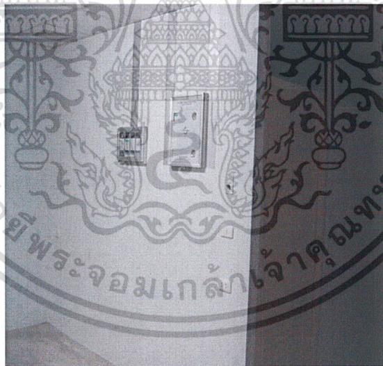
รูปที่ 6.11 ในส่วนจุดพยาบาลดูแลของแต่ละแผนก จะมีตัวควบคุมส่วนกลางหรือบอกระดับปริมาณก๊าซต่างๆ ของในแผนก เพื่อควบคุมหรือตรวจสอบได้ หากมีสิ่งผิดปกติเกิดขึ้นได้
