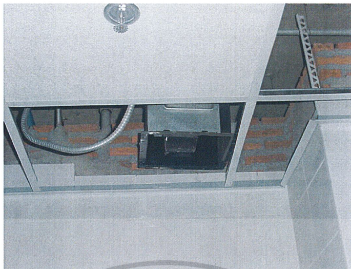
รูปที่ 6.17 พัฒนาระบายอากาศแบบ Ceiling – Mount จะมีท่อสำหรับต่อท่อลม โดยในปล่องจะมีพัดลมหยอโขงเป็นตัวช่วยระบายลมออกไปตามท่อระบายลมออกสู่ภายนอก
