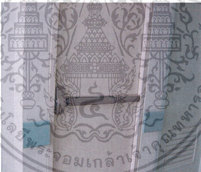
รูปที่ 6.25 ส่วนประตูกุญแจไฟจะเป็นประตูกุญแจพิเศษ คือ ใช้การผลัก ซึ่งง่ายต่อการเพียงแค่ดันออก ก็สามารถเปิดได้ โดยทั่วไปจะเป็นแบบเปิดได้ทางเดียว
