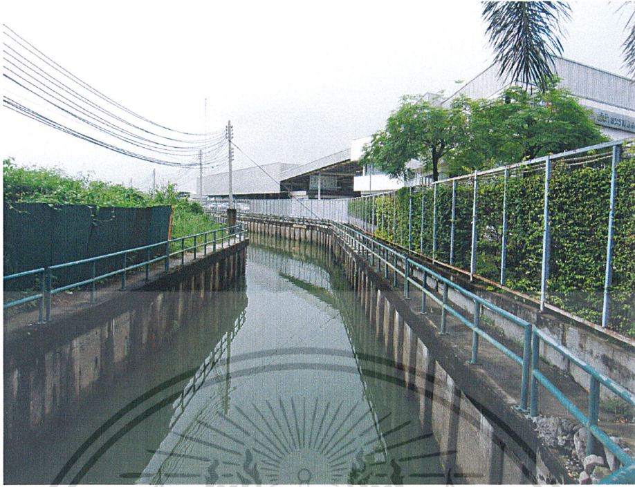
รูปที่ 5.14 ทางระบายน้ำ
