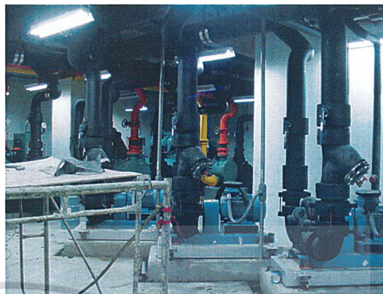
รูปที่ 6.1 เครื่องทำความเย็น, เครื่องสูบน้ำเย็นและเครื่องระบายความร้อน, แผงควบคุมและเครื่องลดความกระด้างของน้ำที่ใช้ในการส่งจ่ายน้ำเย็น โดยจะแยกท่อสำหรับส่งน้ำเย็นจะมีฉนวนหุ้ม
