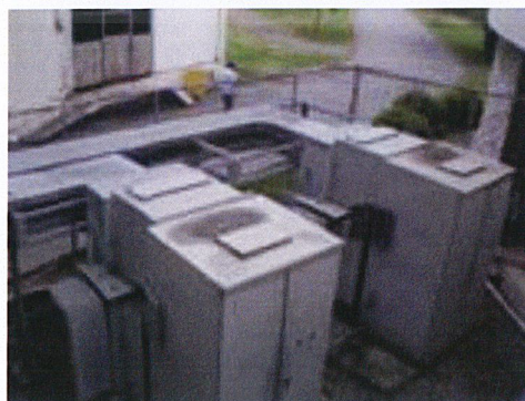
รูปที่ 3.21 ส่วนควบคุมระบบไฟฟ้าของอาคาร อินดอร์สเตเดียม หัวหมาก
