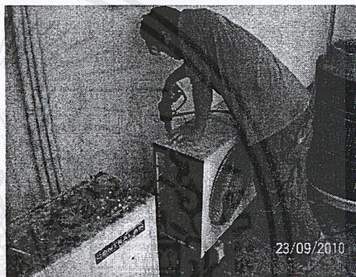
รูปที่ 4.4 การทำความสะอาดเครื่องปรับอากาศส่วนในห้อง (Fan Coil Unit) และนอกห้อง (Condensing Unit)
