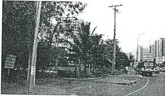
รูปที่ 5.16 ด้านหน้าโครงการ
