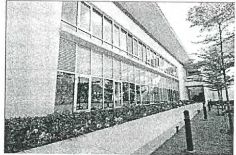
รูปที่ 3.39 ทางเดินด้านข้างอาคาร OPD
