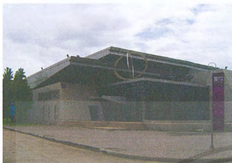
ภาพที่ 4 มองจากด้านหน้าอาคาร
