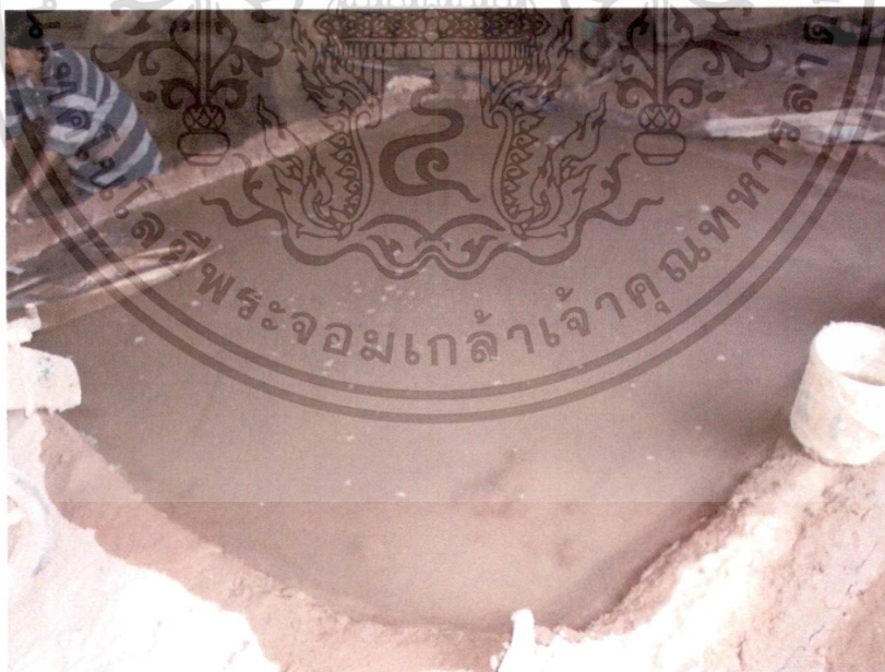
ภาพที่ 4.10 บ่อบ่มดินที่ผ่านการผสมดินแล้ว
