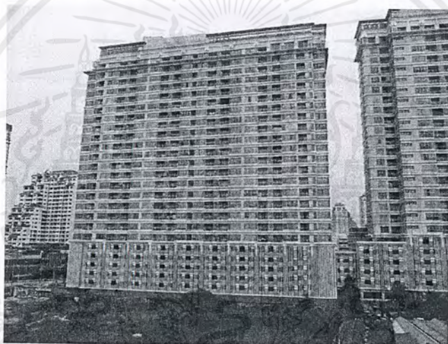
ภาพที่ 5.3.1 แสดงทัศนียภาพที่ตั้งโครงการทิศตะวันออกเฉียงใต้ คอนโดมิเนียม บ้านกลางกรุง
