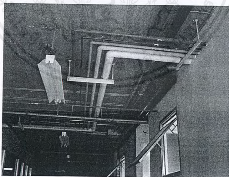
รูปที่ 6.14 เนื่องจากท่อของโครงการ โรงพยาบาลนั้นมีอยู่หลายชนิดโดยทั่วไปจะใช้สีในการแยกประเภทของท่อ - สีเลือดหมู ท่อน้ำทิ้ง
