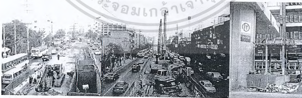
ภาพที่ 1.4 ภาพแสดงพื้นที่ก่อสร้างจริง
