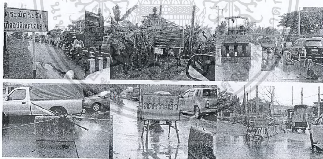
ภาพที่ 2.174 การก่อสร้างบริเวณถนนกัลปพฤกษ์
