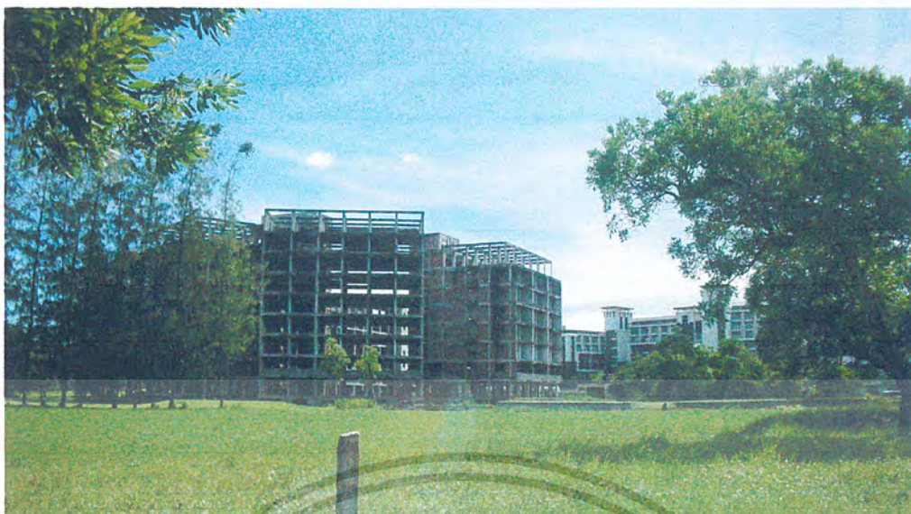
ภาพที่ 1.5.2 รูปอาคารอพาร์ทเมนต์เก่า
