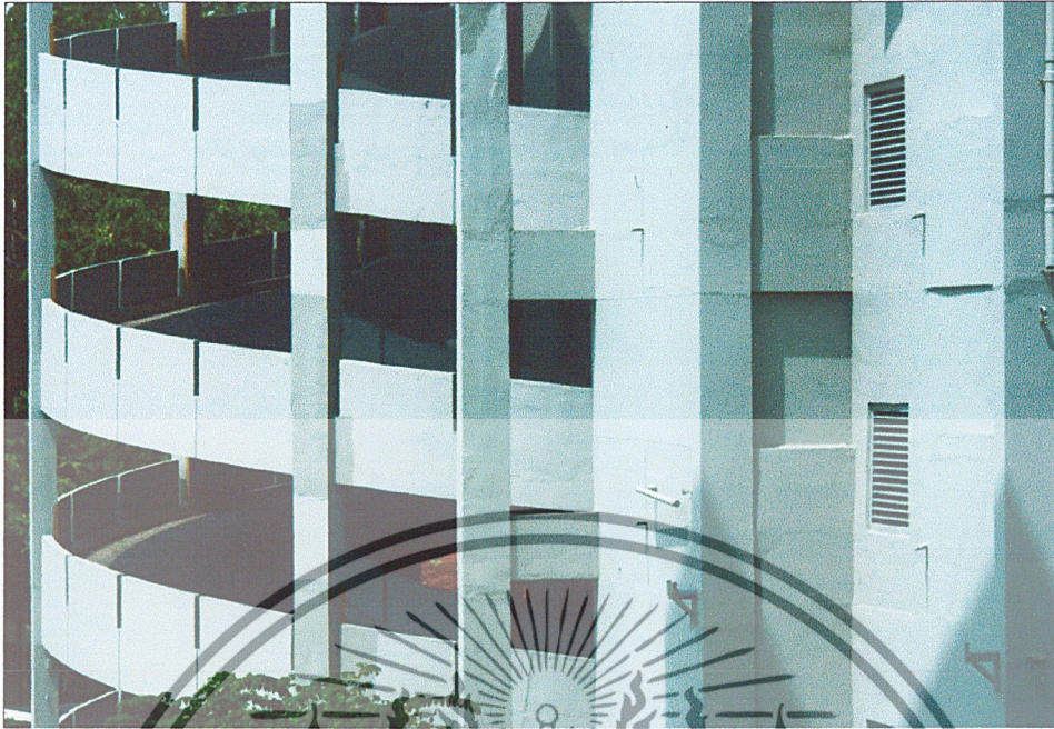
รูปที่ 2.14 ภาพโครงสร้างสถาปัตยกรรมอาคารจอดรถ
