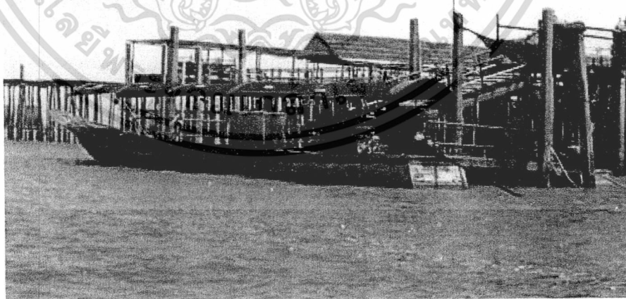
ภาพที่ 4.16 แสดงสถานที่ที่ทำการสำรวจที่หมายตาของชุมชนริมชายฝั่งทะเลบางขุนเทียน ที่มา : จากการสำรวจเดือนกุมภาพันธ์ 2554
