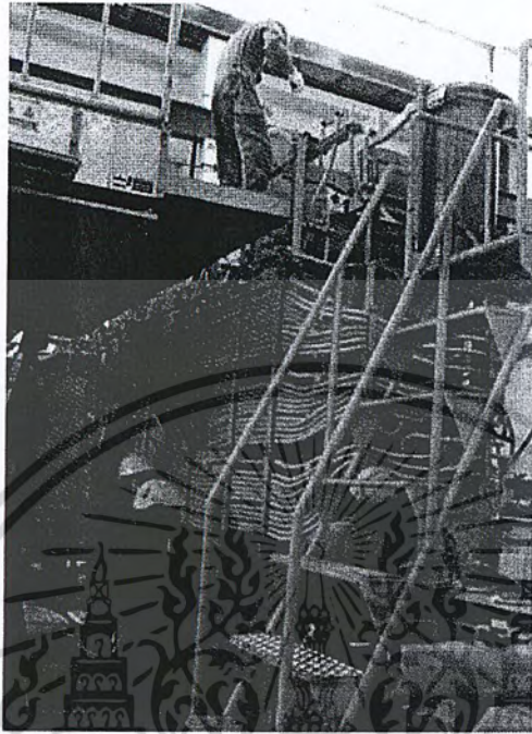
รูปที่ 3.4 ขันน็อตตามจุดต่างๆ บนไส้ในหม้อแปลงไฟฟ้า
