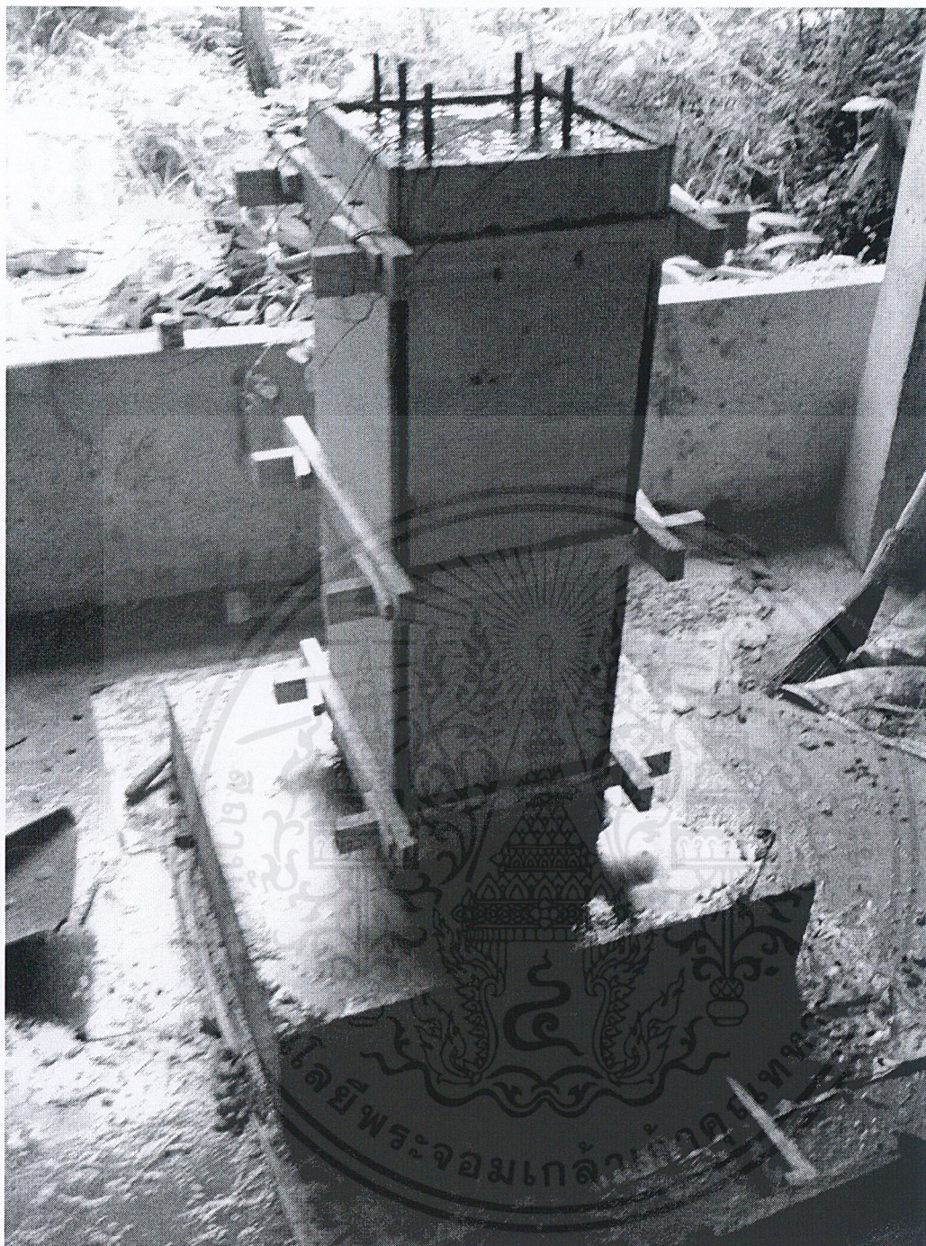
รูปที่ ผ.ค.70 การเข้าแบบเสา
