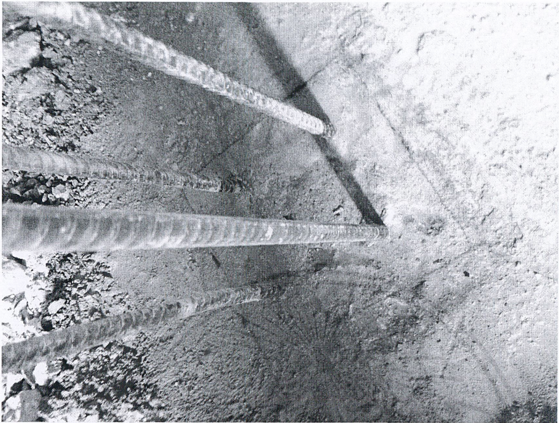
รูปที่ ผ.ค. 85 แสดงแนวขอบเสาเดิม(สีน้ำเงิน)และคราบสีผสมอาหาร(สีแดง)บนฐานราก
