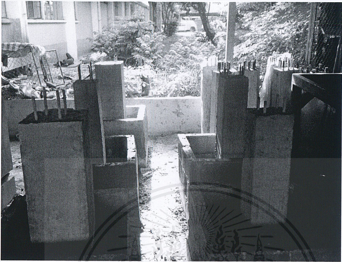
รูปที่ ผ.ค.74 หลังจากก่อสร้างตัวอย่างทดลองทั้งห้าแล้วเสร็จ
