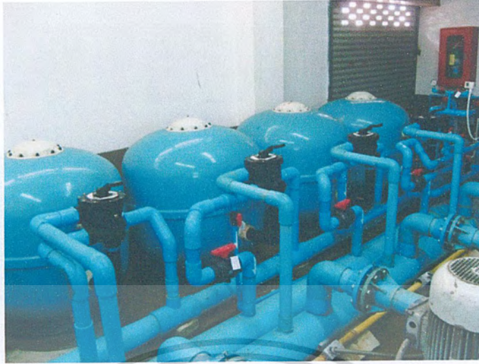
รูปที่ 3.8 ระบบกรองน้ำ (ขนาดท่อที่ใช้กับถังกรองใช้ท่อขนาด 3 นิ้ว)
