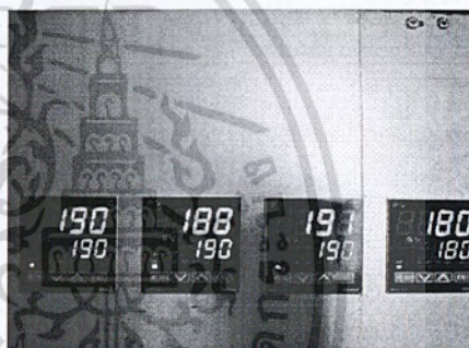
รูปที่ 4.4 ทำงานของฮีดเตอร์จนถึงอุณหภูมิที่ตั้งค่าไว้
