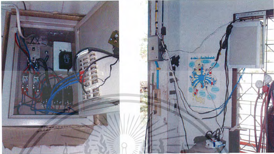
รูปที่ 4.3 การติดตั้งกล่องควบคุมอุณหภูมิ
