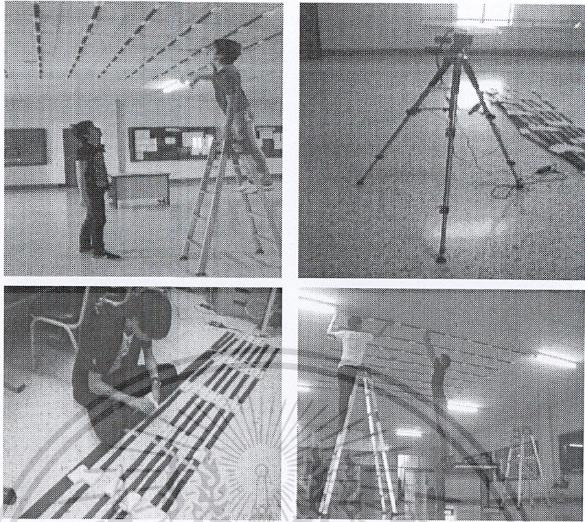
รูปที่ 4.8 แสดงภาพรวมของแท็กทุกตัวที่ติดตั้งเสร็จแล้ว
