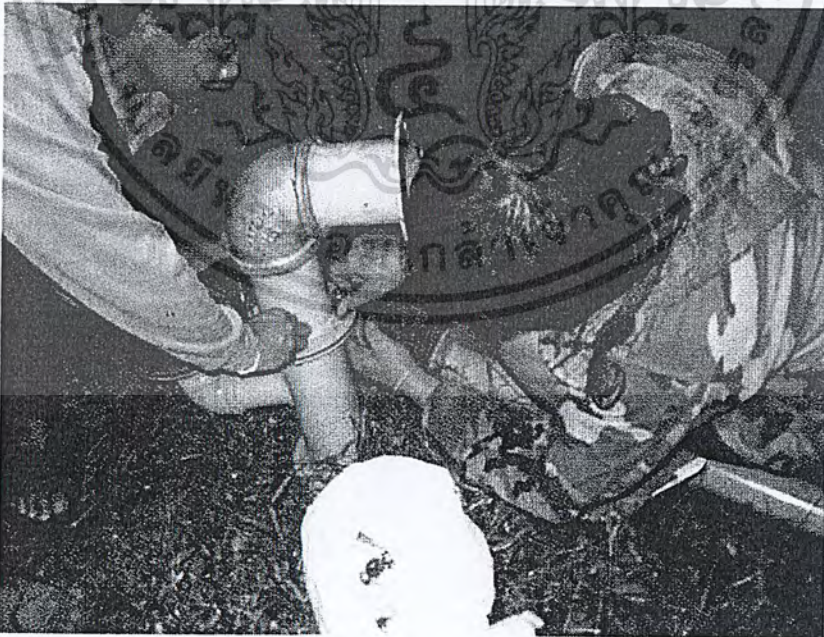
รูปที่ ก 2 การประกอบชุดท่อ ejector
