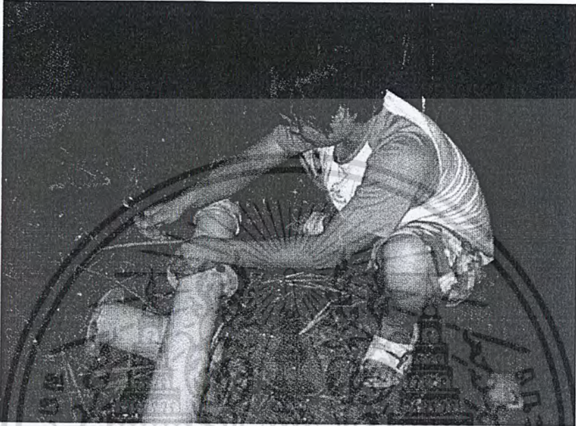
รูปที่ ก1 การประกอบชุดท่อทางดูด Foot Valve
