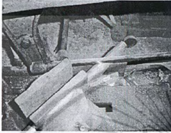
ภาพที่ 3.4 การตัดเหล็กมุม 45 °
