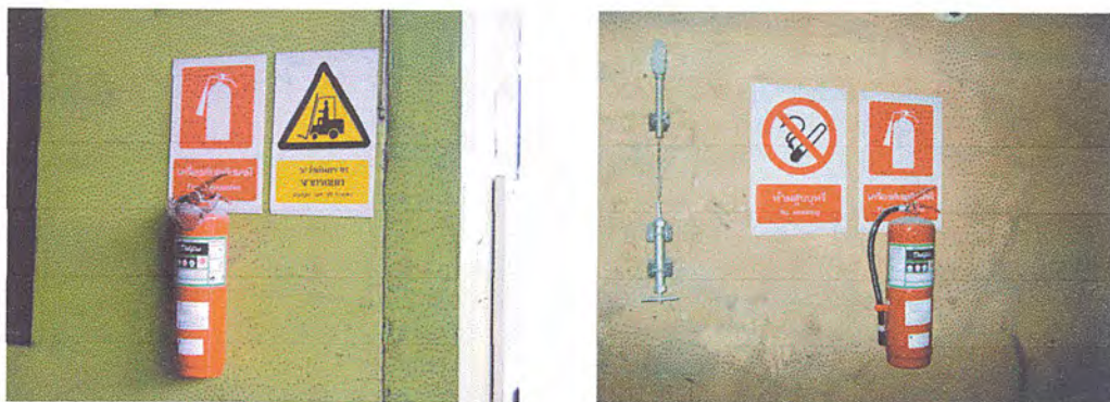
รูปที่ 5.13 มีการติดตั้งถังดับเพลิงเพิ่มเติมอย่างเพียงพอหากเกิดเหตุเพลิงไหม้
