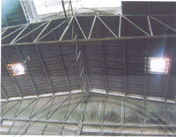
รูปที่ 5.10 การติดตั้งลูกหมูระบายอากาศบนหลังคาโรงงาน เพื่อช่วยระบายความร้อนในพื้นที่ทำงาน
