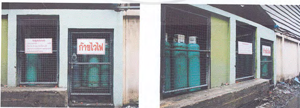
รูปที่ 5.12 บริเวณเก็บถังแก๊ส LPG ที่ใช้เป็นเชื้อเพลิงของโรงงานในปัจจุบัน
