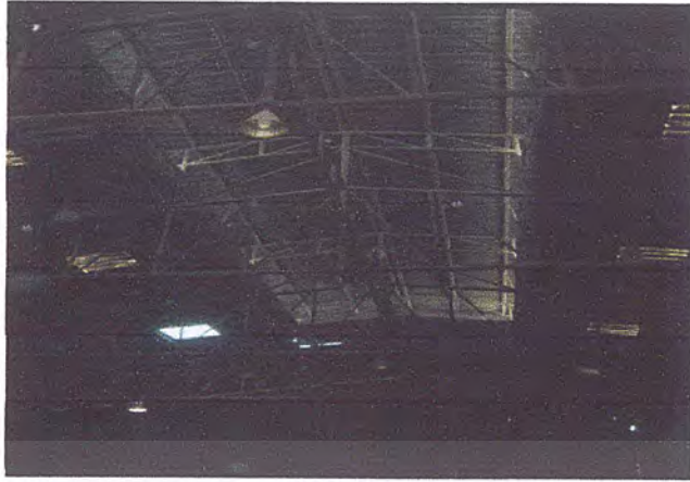
ภาพก่อนปรับปรุง
